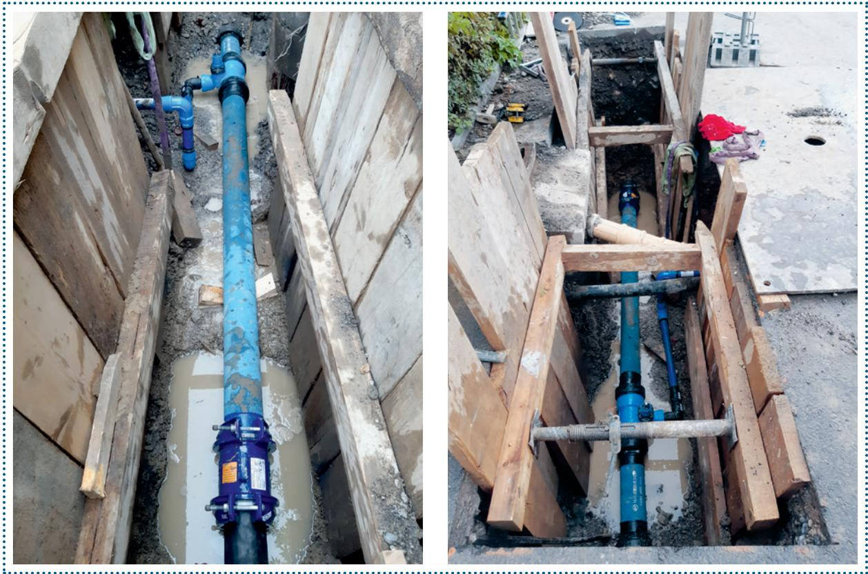
Aufwendige Tiefbauarbeiten im Zusammenhang mit dem Leitungsbau der Wasserversorgung. (Fotos: Reto Zürcher)
