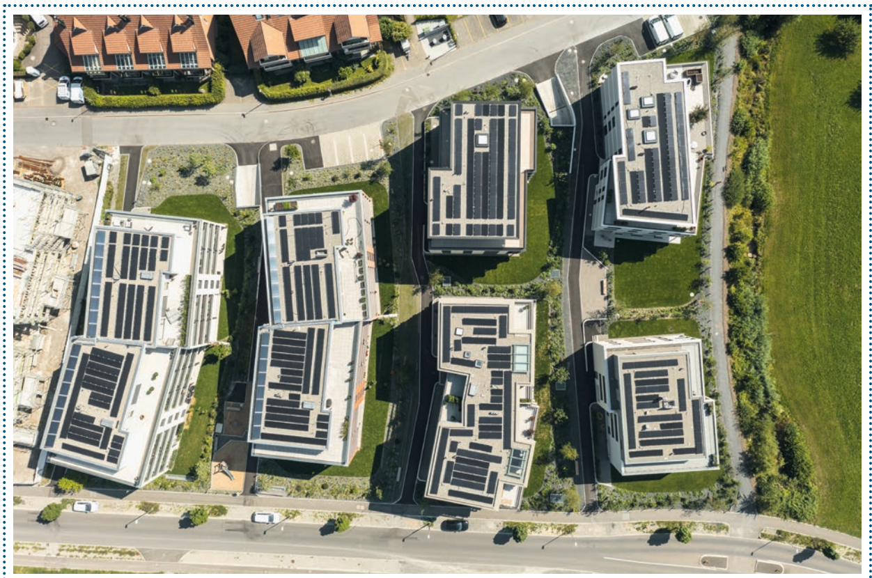
PV-Anlage auf Cluster Mitte und Cluster Süd sind zum ZEV 1 zusammengefasst
