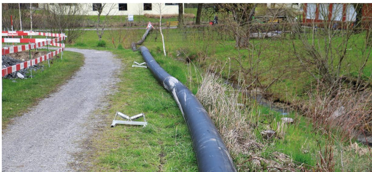
Vorbereitung des Schutzrohres für die Unterbohrung der Lorze und Zugerstrasse im Zimel
