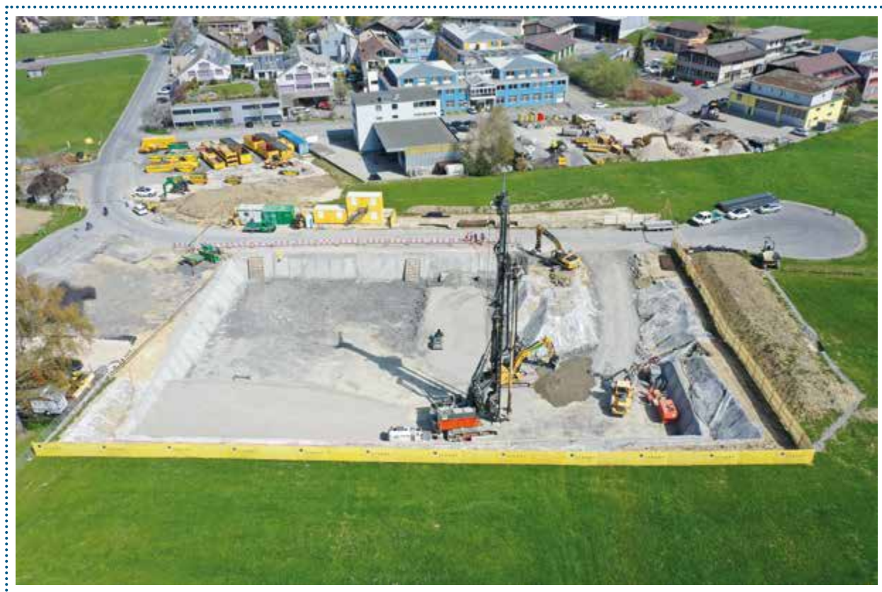
Baugrube für die Heizzentrale Rain mit Gewerbebau
