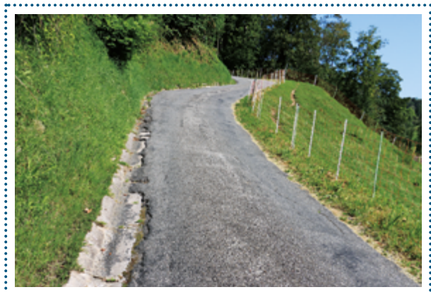
Strasse Richtung Liegenschaft Hodel
